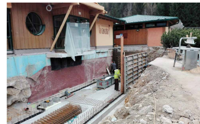
In der Pizzeria am Badesee wurden 2017 die Kellerräume dazu gebaut.
