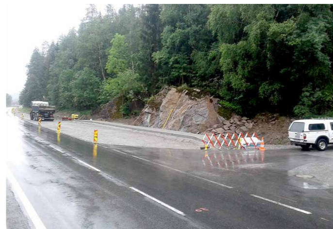
3 Linksabbieger wurden entlang der Öztaler Bundesstrasse gebaut.
