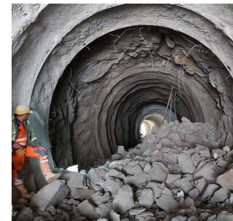
Der Durchschlag beim insgesamt 820 Meter langen Druckstollen ist im Frühjahr 2021 erfolgt.
