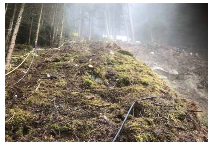
Eine großflächige Vernetzung wurde angebracht.
