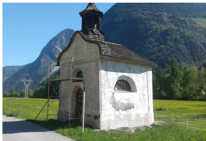
Eine umfangreiche Restaurierung der Kapelle in Hopfgarten wurde umgesetzt.
