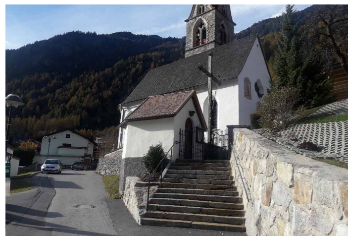
Bei der Friedhofskapelle in Tumpen wurde das Dach saniert.
