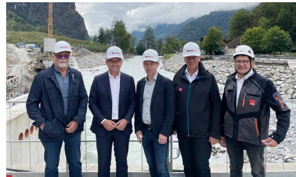
Hoher Besuch auf der Kraftwerksbaustelle in Tumpen: Staatssekretär Magnus Brunner (2.v.li.) mit den Standortbürgermeistern Hansjörg Falkner und Jakob Wolf sowie den beiden Geschäftsführern Klaus Auer (li.) und Klaus Mitteregger (re.).
