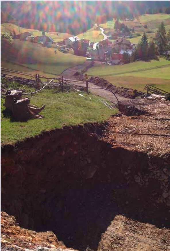
Bauarbeiten Wasserversorgungsanlage Köfels
