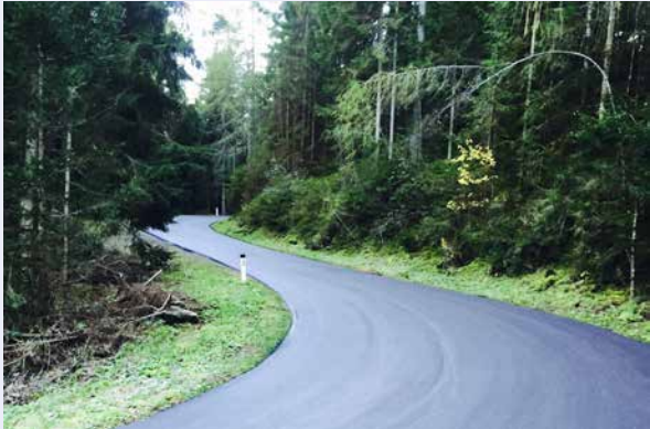
Asphaltierungsarbeiten Köfler Straße
