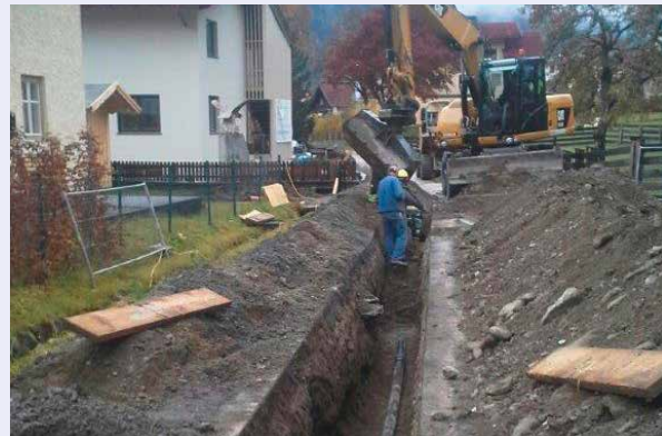
Verlegung Gasleitung
