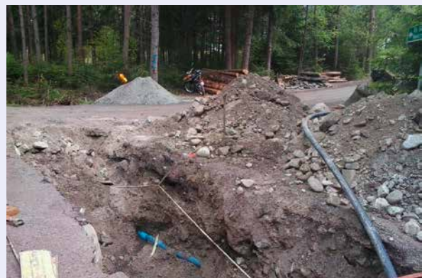
Verlegung Wasserleitung Köfels
