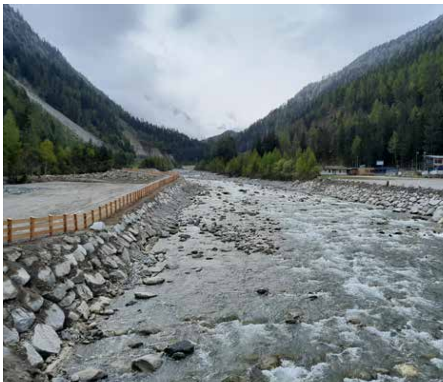
Verbau bei der Köflerstraße
