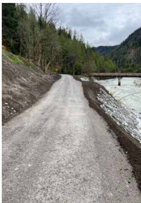
Wiederhergestellter Weg vom Fußballplatz bis zur Fundusbrücke
