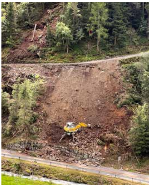
Komplett abgerutscht: Pluiroanweg Niederthai
