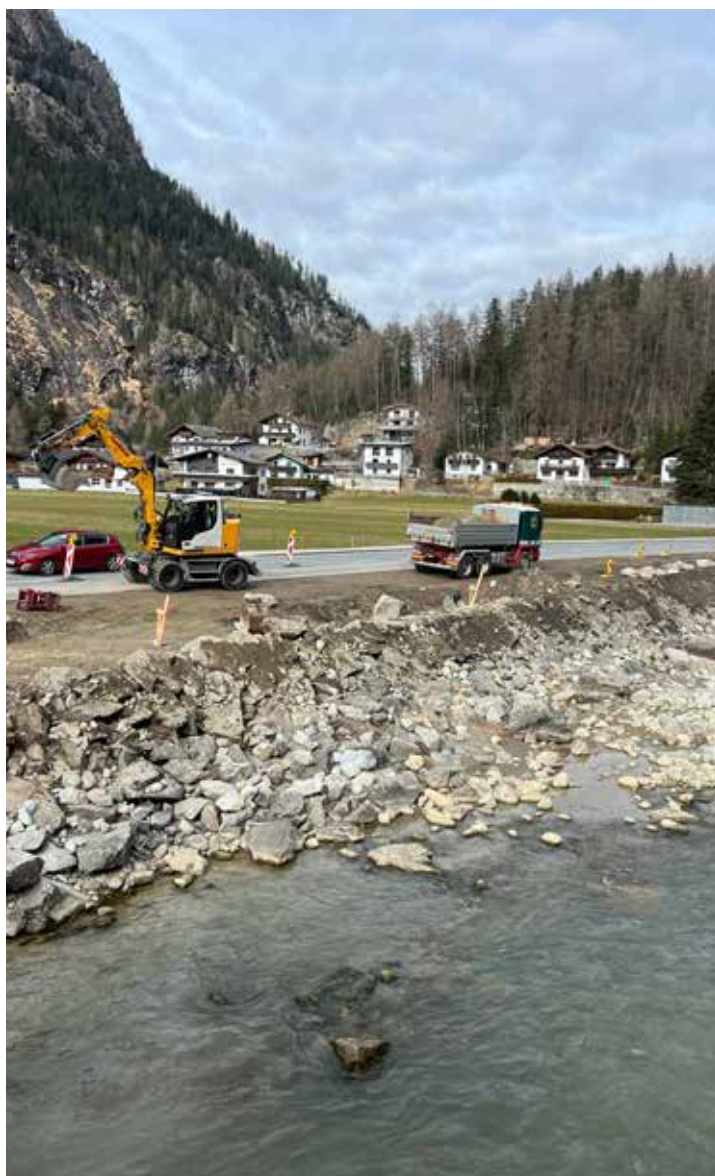
Arbeiten in Tumpen
