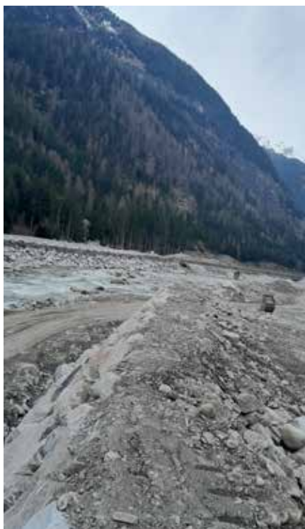
Uferverbauungen bei der Köfler Brücke
