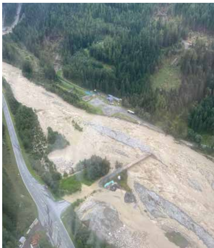
Überschwemmung der Köfler Brücke
