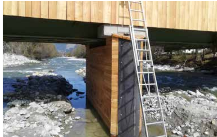
Arbeiten an der Leiersbachbrücke
