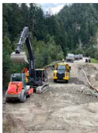
Die Ötztal Bundesstraße wurde rasch wiederhergestellt. Es wurde Tag und Nacht gearbeitet.
