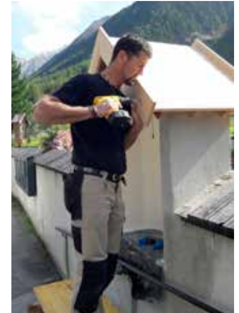
Renovierungsarbeiten: Friedhof und Widum.
