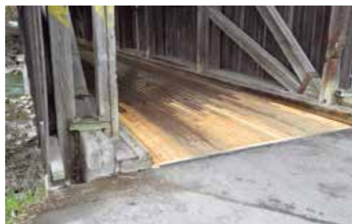
Bei der Leiersbachbrücke wurde der Belag vorne und hinten erneuert.
