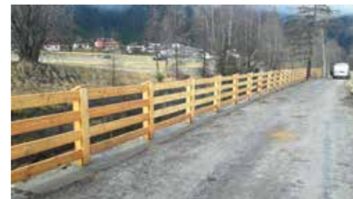
Der Zaun im Bereich des Öztaler Schafwollzentrums wurde erneuert.
