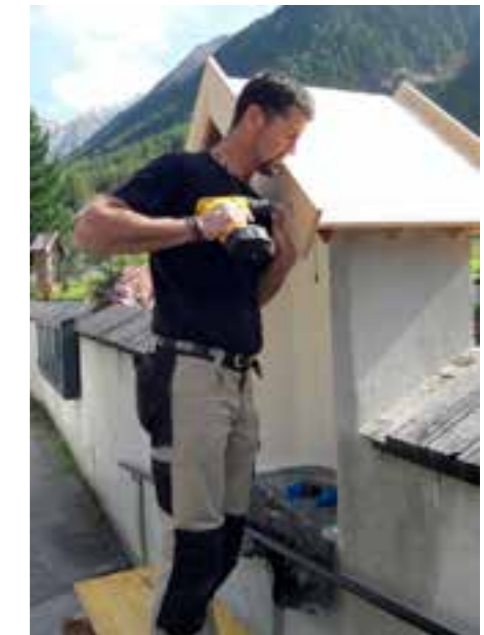
Renovierungsarbeiten: Friedhof und Widum.
