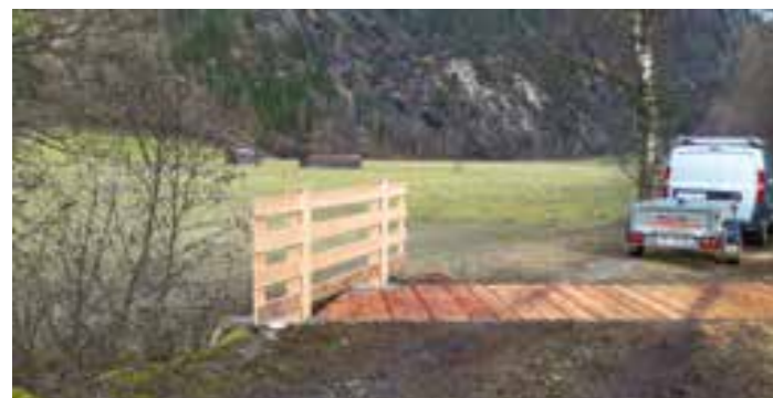
Die Brücke im Bereich Östen/Moos wurde erneuert.
