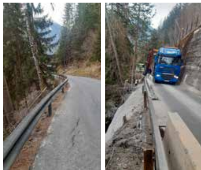
Es wurde wieder ein Teil der Leitschienen entlang der Köflerstraße ausgetauscht. Etwa 130 lfm waren morsch.
