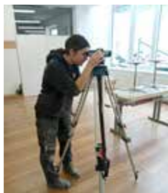
Nivellieren am Bau
