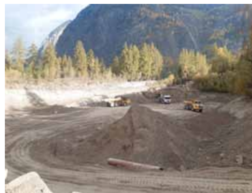
Räumung unteres Becken Farstrinne
