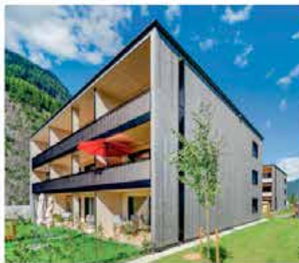
Umhausen, Platzl 1. Bauabschnitt, 24 Mietwohnungen
