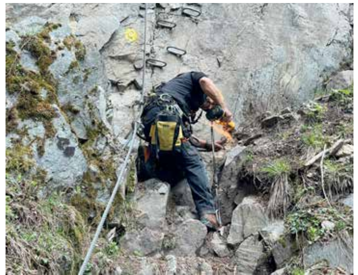
Instandhaltungsarbeiten am Stuibenfall Klettersteig
