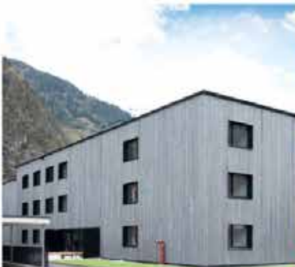
Umhausen, Platzl 2. Bauabschnitt, 12 Mietwohnungen
