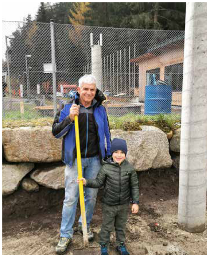
Rodelchef Bruno Kammerlander erhielt bei den Bauarbeiten in der Grantaube auch Hilfe von seinem Enkel Linus.
