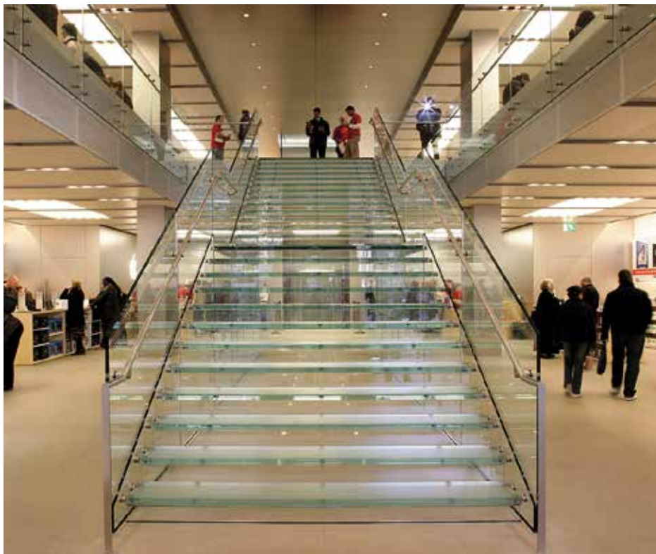
Ganzglastreppe im Apple Store in der Regent Street in London.
