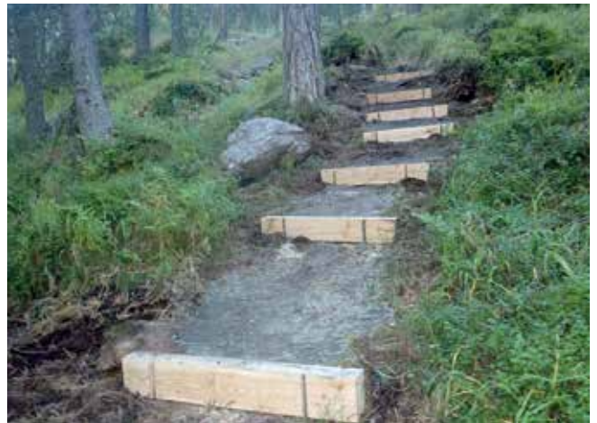
Im Bereich Grastalbrücke / Grastalsteg wurde die Brücke entfernt und ein neuer Weg errichtet.
