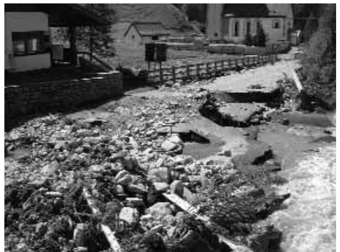
Auch Straßen wurden in Mitleidenschaft gezogen
