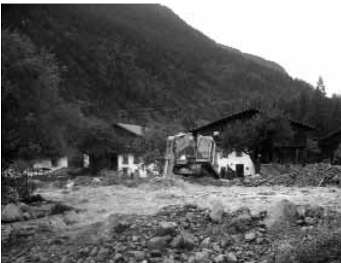
Schwere Hochwasserschäden in der Öster Mure
