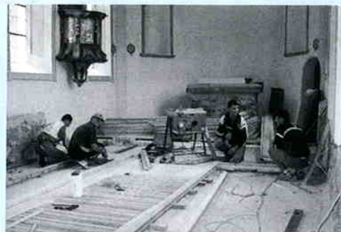
Die freiwilligen Helfer verlegen den neuen Lärchenboden.
