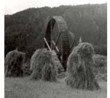
Das überschächtige, mächtige Wasserrad einer längst abgetragenen Sägemühle im Jahr 1972. Heute wird das Objekt durch eine Dachkonstruktion vor der Witterung geschützt.
