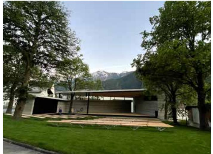
Wärmeschutz, Luftdichtheit, etc. erfüllen. Daher wurden die Wände in Stampfbeton ausgeführt. Durch diese alte Bauweise entstehen durch die lageweise Einbringung des Betons horizontale Bänder, die an das Gestein des Strahlkogels erinnern. Diese Optik
